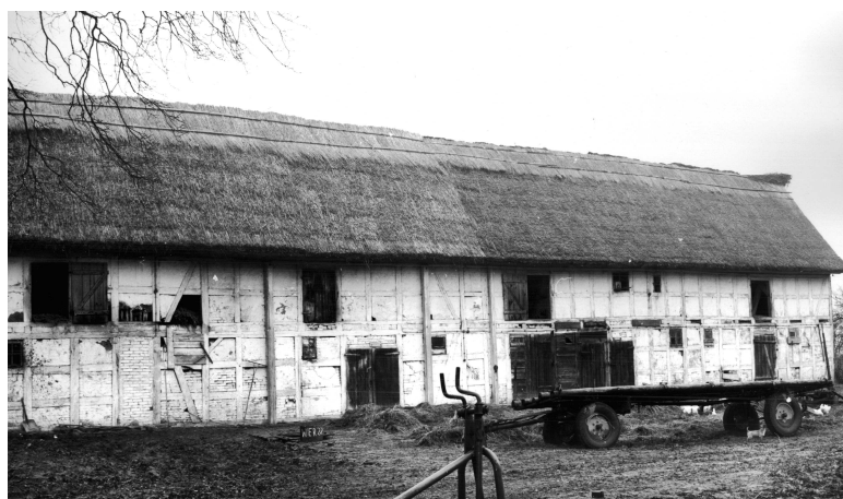
Ryc. 11. Wierciszewo nr 22. Budynek inwentarski w zagrodzie pełnorolnej. Fot. G. Solecki, 1973 (zbiory ROBiDZ w Szczecinie)
